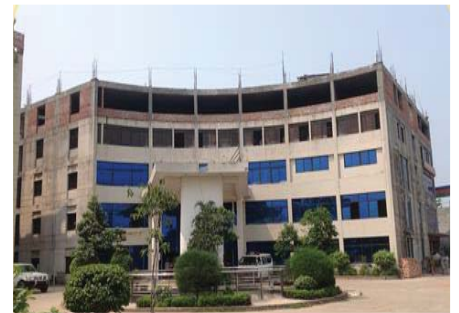
EWMCH既存病院
